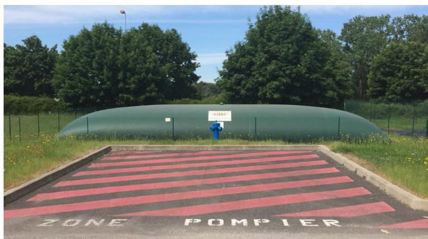
*Aire d'aspiration perpendiculaire au point d'eau (ZI du Ponteix à Feytiat)*
