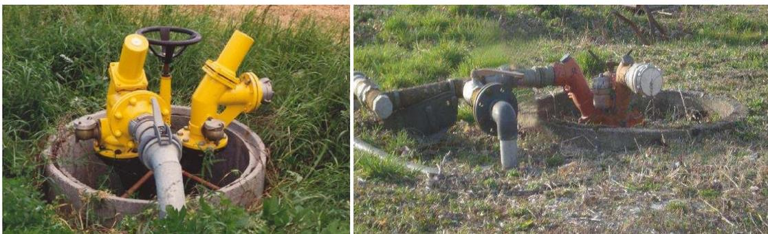
Exemples de prises d'eau agricole (raccord de 65 ou 100 mm)
