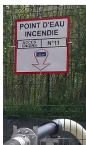
Exemple de signalisation d'un réservoir d'incendie
