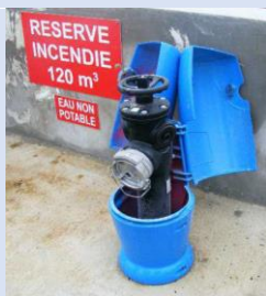
Poteau d'aspiration de 100 mm , muni d'une sortie de 100 mm
