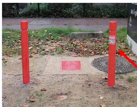
Signalisation d'une BI par potelet
