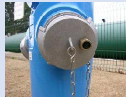
Poteau d'aspiration de 150 mm muni d'un Airclap
