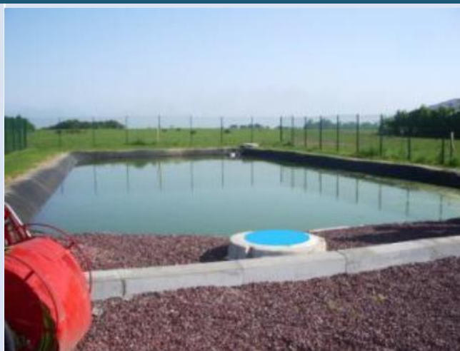
Puisard déporté (tampon circulaire bleu)
