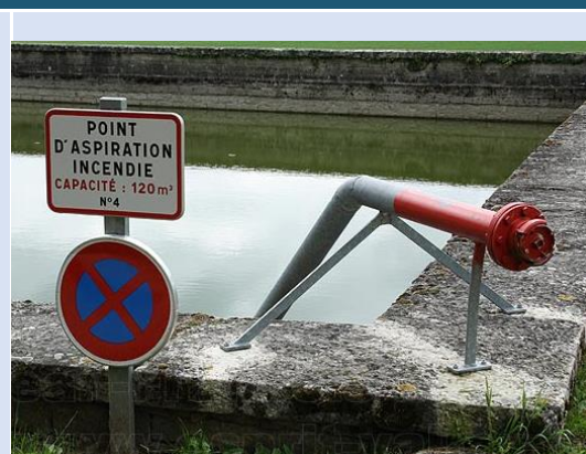
Colonne d'aspiration DN 100
