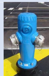
Poteau d'aspiration de 150 mm , muni de 2 sorties de 100 mm
