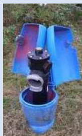
Poteau d'aspiration de 100 mm , muni d'une sortie de 100 mm
