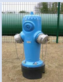
Poteau d'aspiration de 150 mm , muni de 2 sorties de 100 mm
